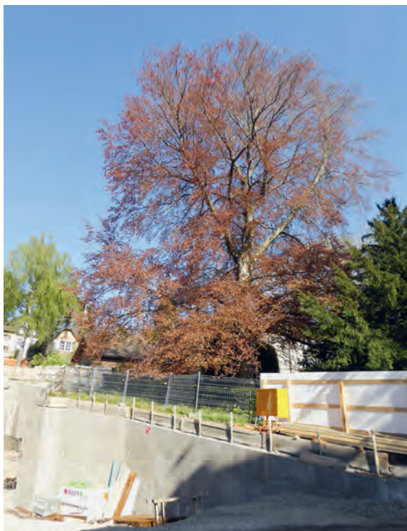
Abb. 1: Einen effektiven Schutz der alten Blutbuche bewirkt der außerhalb der Kronentraufe aufgestellte Baumschutzzaun.
