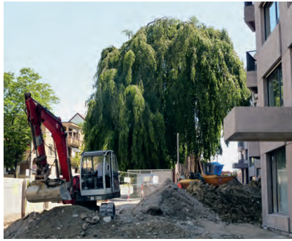
Abb. 8: Ausführungsplanung unter Berücksichtigung des Baumschutzes: Die Mauer an der Straße bleibt erhalten, neue Wege sind außerhalb der Krone geplant, keine Unterpflanzung unter der Krone.
