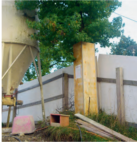
Abb. 2: Nach Voruntersuchungen zum Baumschutz empfohlener vertikaler Baugrubenverbau ausserhalb der Kronentraufe zum Schutz des Wurzelwerks, während in anderen Bereichen abgebösch werden konnte.
